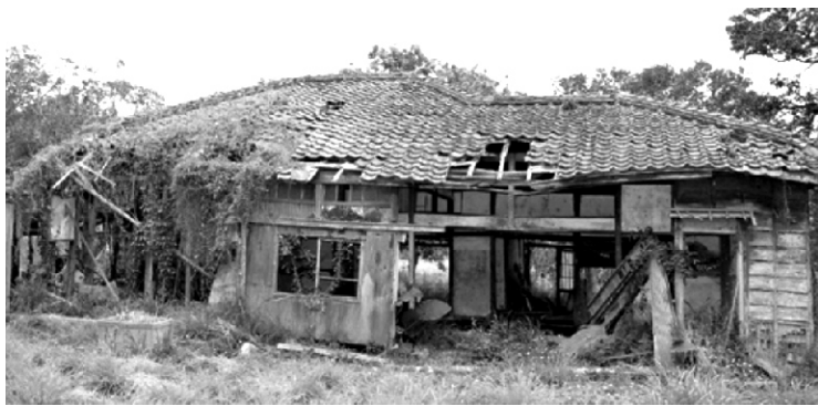
「八田與一紀念園區」預計兩年後完成，圖為八田與一當年居住寓所的殘破現況，這棟建物經整修後，未來將是紀念園區的地標。
